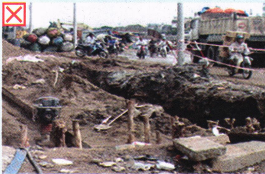
Ao, hố nước nơi công cộng không có rào chắn
